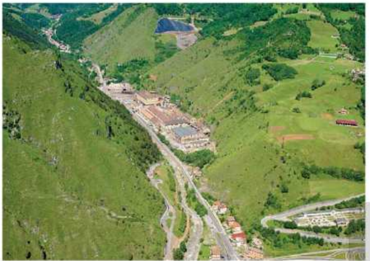
Figura n. 2. Stabilimento Pontenossa S.p.A., Ponte Nossola (Bergamo).
